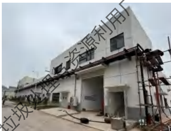
污水处理臭气密闭收集管道
