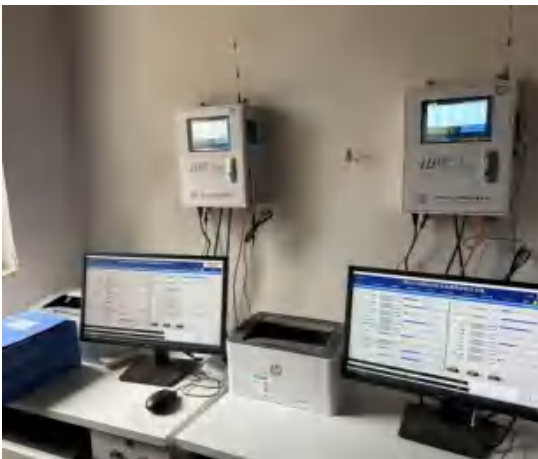
烟气在线监测装置（数采仪）
