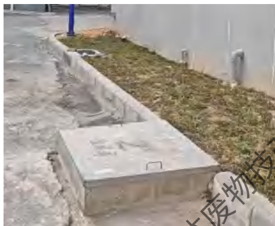
地下水监测井2#
