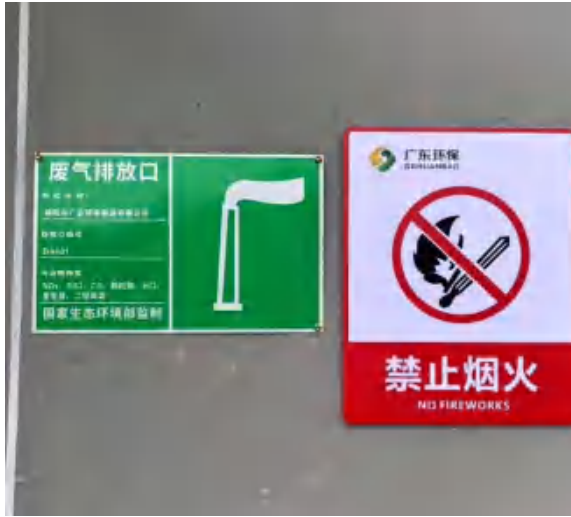
1号焚烧炉废气排放口环保标识牌
