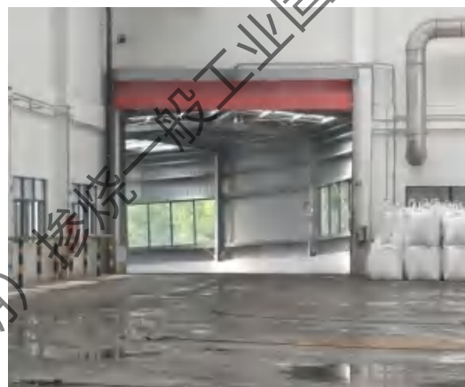
卸料大厅进出口
