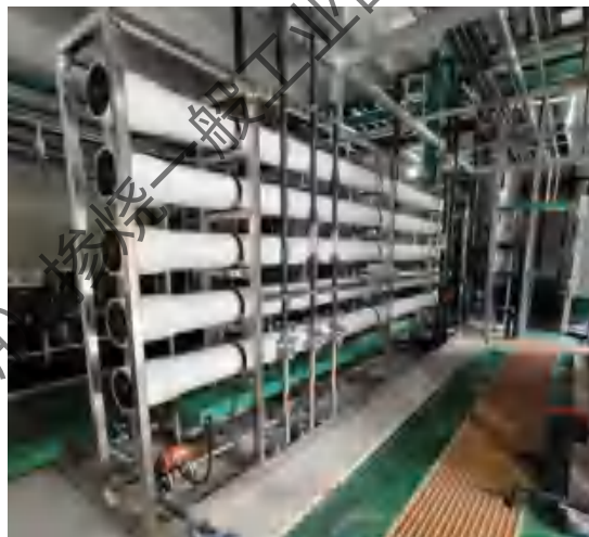
工业废水处理（反渗透）
