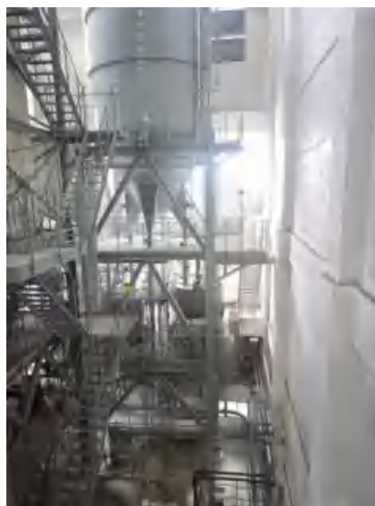
石灰浆制备间
