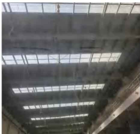
卸料大厅除臭收集
