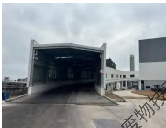
垃圾运输车进出口
