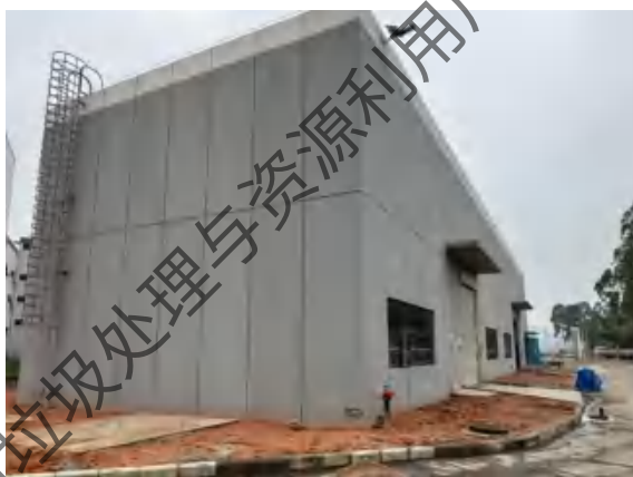
飞灰固化物养护间及危废暂存间
